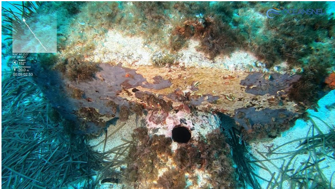
Imagen 6: Orificio difusor junto a lastre.
