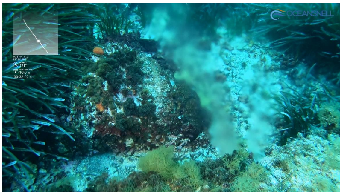
Imagen 22: Fuga en la conducción.
