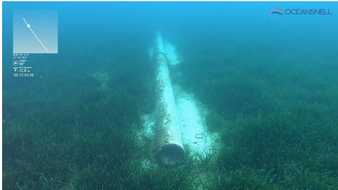
Imagen 13: Resto de conducción desconectada.
