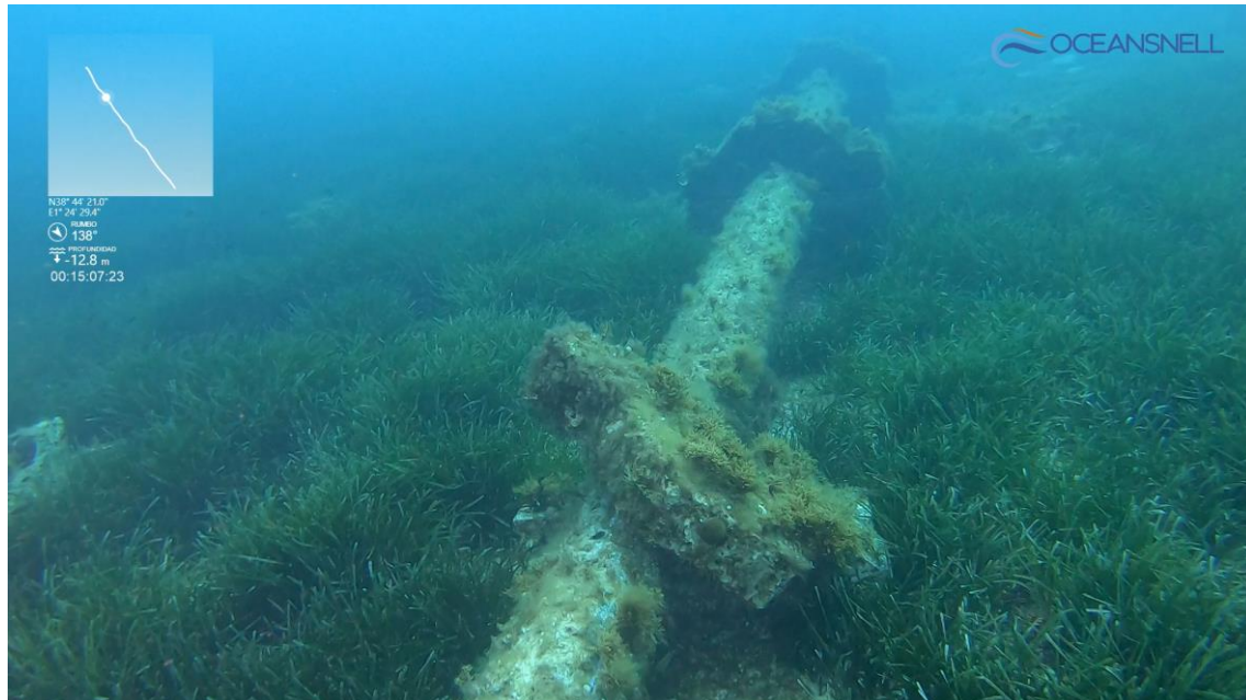
Imagen 17: Lastre sobre la conducción.
